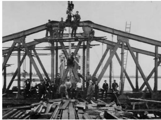
Foto oben: Das Drehteil wird errichtet.
