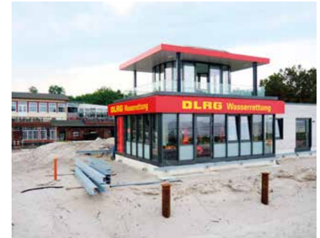
Siebenter Rettungsturm 2024, kurz vor der Fertigstellung. Foto: Mohr
