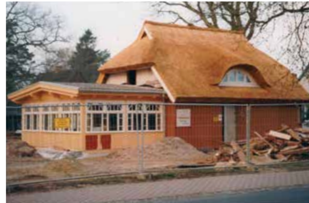
Die Teeschale in der Bauphase.
